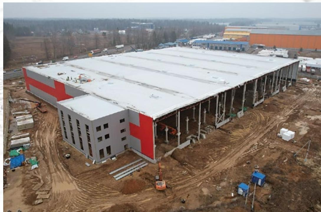
Выполнен монтаж кровли с поставкой материалов под ключ на складском корпусе логистического парка «Радумля». Общая площадь кровли – 21 000 кв. м.
