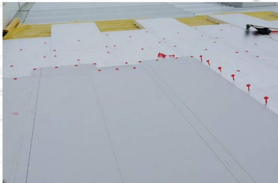
Выполнен монтаж кровельного пирога на ФОК в г. Щербинка. Утеплитель PIR (PIRROGROUP), гидроизоляция – ПВХ-мембрана. Площадь 3500 кв. м.
