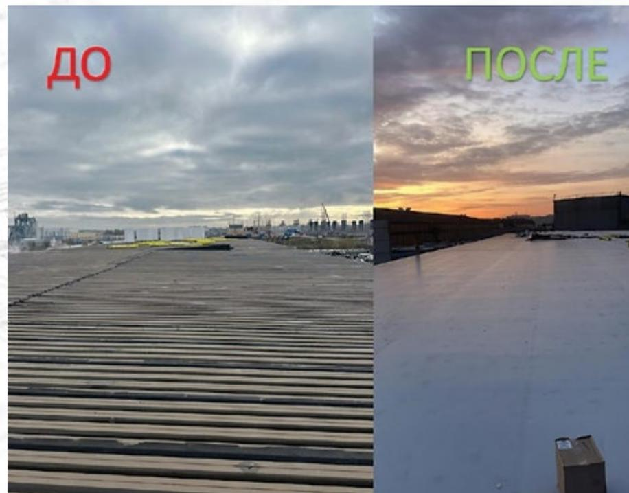
Ремонт (демонтаж, монтаж) кровли здания по сбору и прессованию металла
