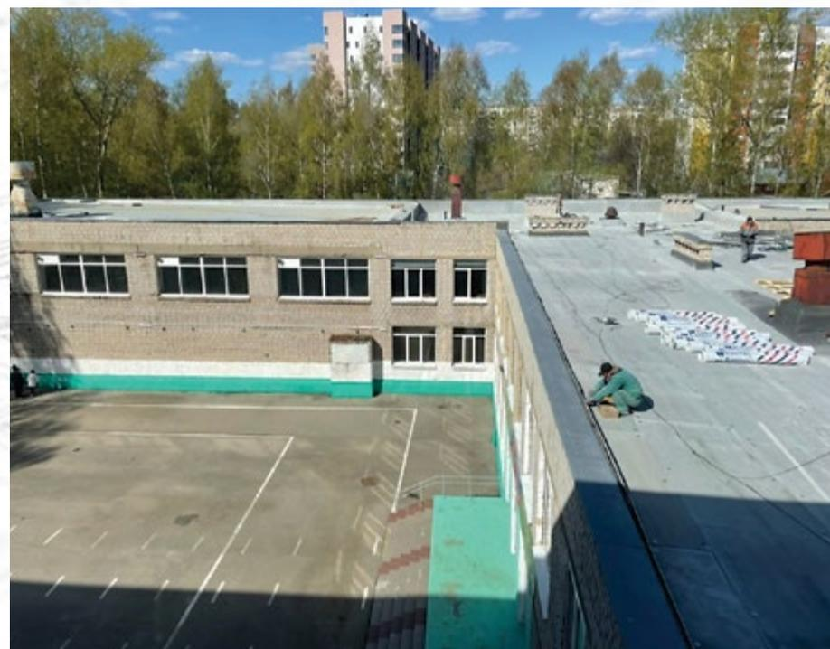
Произведен текущий ремонт кровли здания школы № 47 в г. Рязани, площадь 1500 кв. м. Поставлена гидроизоляция и сопутствующие материалы под ключ.
